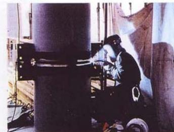
鋼管柱の溶接
