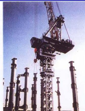
鋼管柱の吊込み
